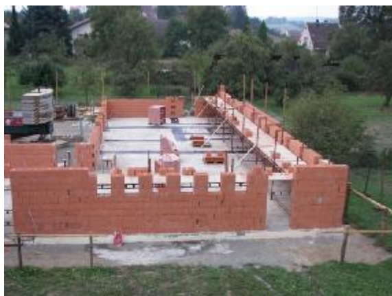
Stavba bytového domu byla zahájena a úspěšně pokračuje
